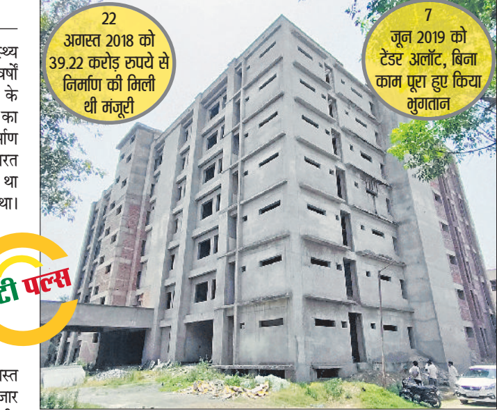
बहादुरगढ़ । अस्पताल में अधूरा पड़ा नए भवन का निर्माण ।
